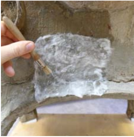
FIG. 323 Application d'une compresse imbibée d'acétone à 80 % et de White Spirit à 20 %.
