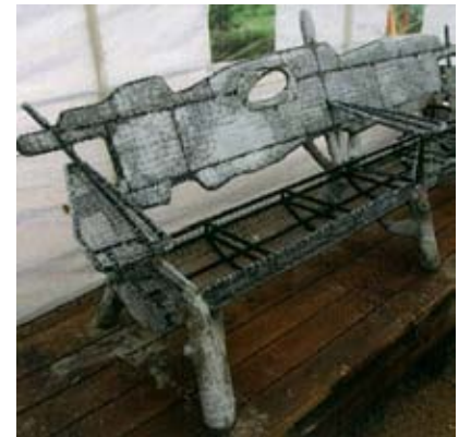
FIG. 114 Remplissage du grillage avec un mortier de ciment maigre (©D. Tucker).
