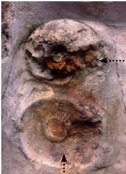
FIG. 278 Pyritisation active de G2 ayant engendré des coulures d'oxydes de fer sur G3.
