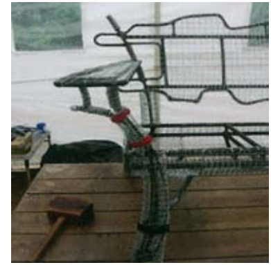
FIG. 111 Étape n° 3, habillage des surfaces pleines par un grillage (©D. Tucker).
