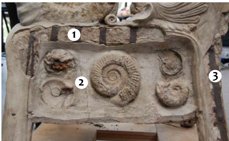
FIG. 256 Directions des fissures en fonction de l'emplacement des armatures corrodées :
