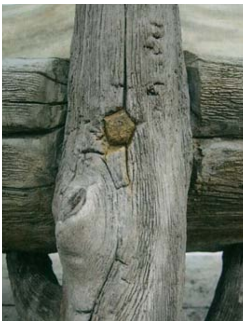
FIG. 115 La dernière couche de mortier est texturée parfois d'une manière très illusionniste (D. Tucker).
