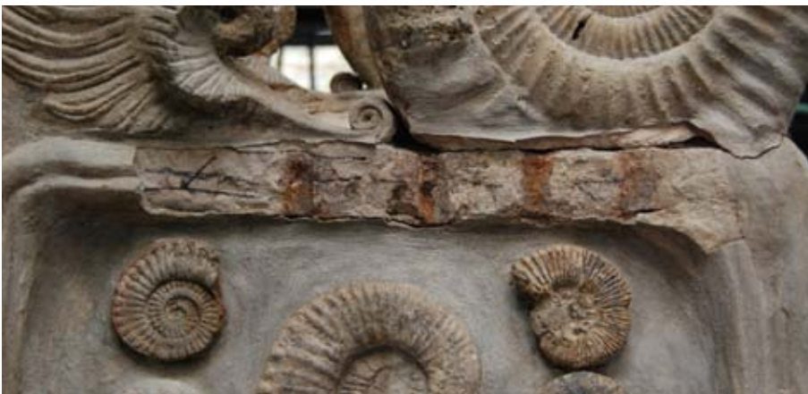
FIG. 354 Panneau droit, après dépose de la moulure haute.
