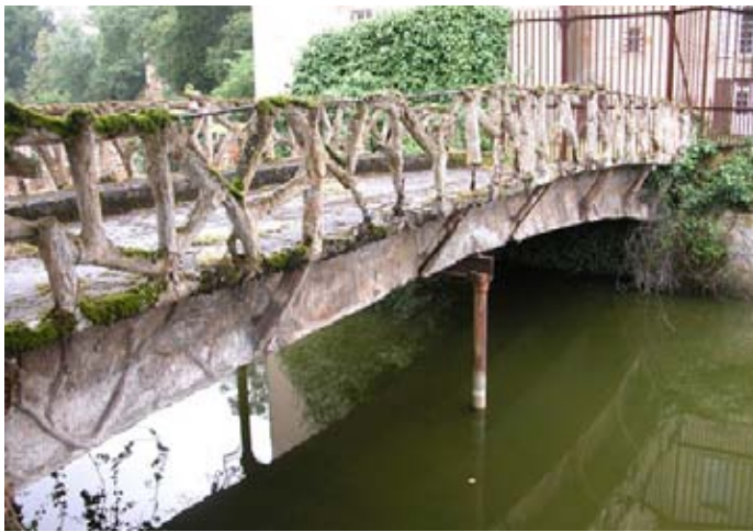
FIG. 94 Le pont du château de Chazelet (Indre), conçu par J. Monier en 1875, est le premier pont construit en ciment-armé en France (L. 13,80 m, l. 4,25 m).
