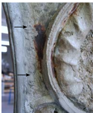
FIG. 342 Des débordements de ciment recouvrent les bords du dossier.
