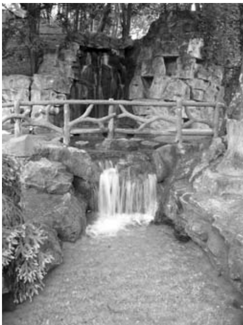
FIG. 101 Parc des Buttes-Chaumont, aménagement typique d’une cascade et d’un garde-corps en faux-bois.
