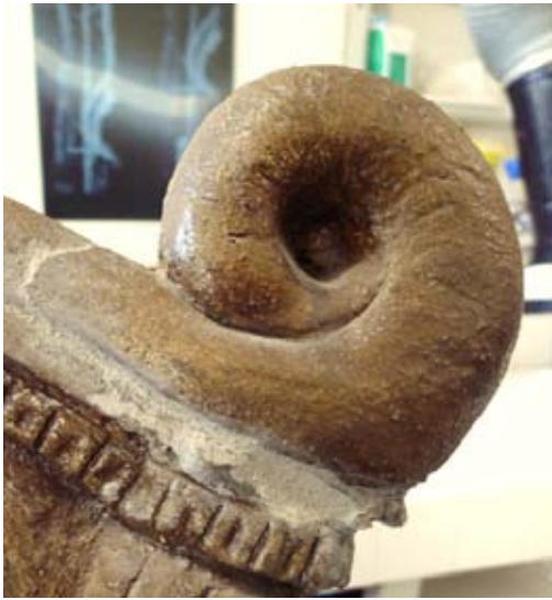
FIG. 212 Refixage de F11 au ciment-colle (face avant).
