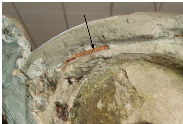
FIG. 144 Barre en fer plat au dessus du dossier.
