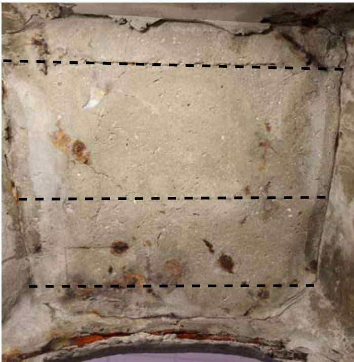
FIG. 138 Dessous de l'assise, délimitation des planches ayant servi au coffrage.
