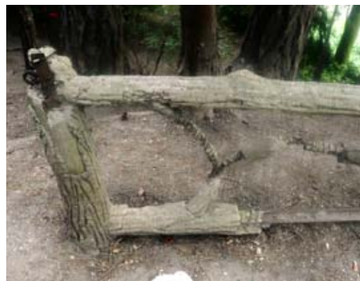
FIG. 113 Jardin des Buttes Chaumont à Paris, détail d'un garde corps en « faux-bois » datant de 1866. Les armatures sont enroulées de fil de fer.
