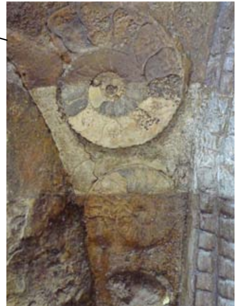
FIG. 331 Le dégagement de la patine brunâtre a permis de révéler les couleurs des fossiles (ici F6 et F7).
