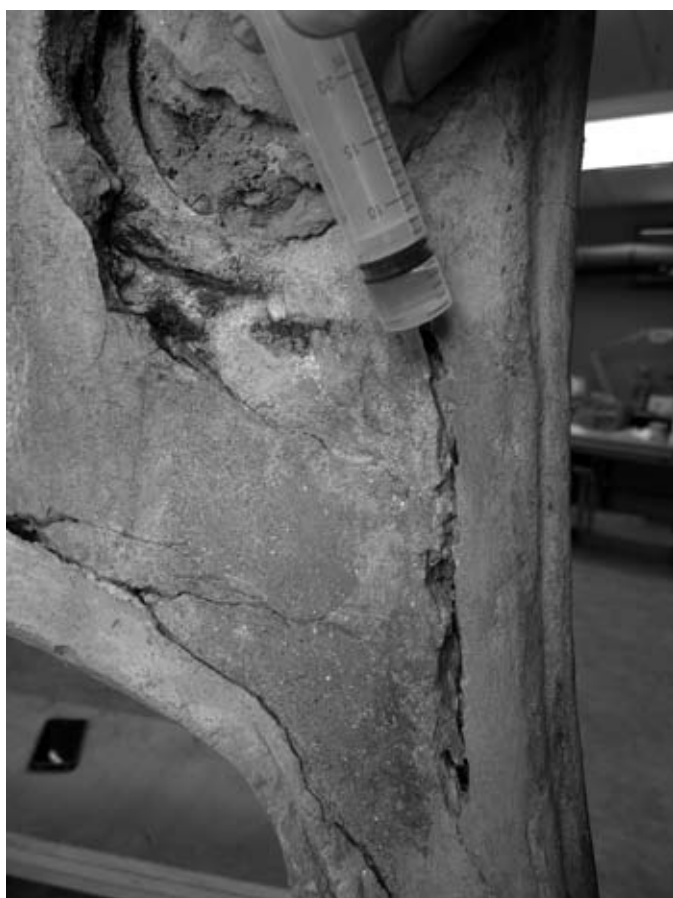
FIG. 381 Traitement des armatures métalliques, ici par injection à la seringue (armature inaccessible du pied arrière droit).
