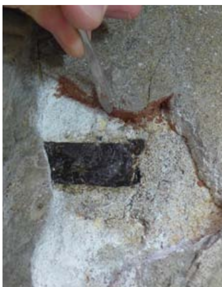
FIG. 393 Bouchages structuraux réalisés sur les fragments de l'assise.
