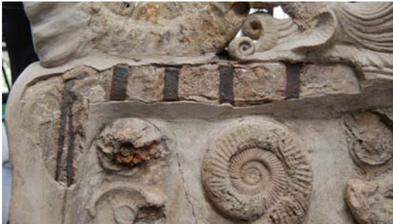
FIG. 370 Armatures métalliques du panneau gauche après élimination de la rouille par projection de micro-billes de verre.
