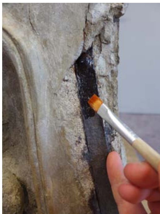
FIG. 386 Application au pinceau de Rustol Owatrol® sur les armatures accessibles.
