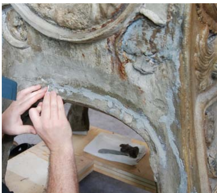
FIG. 312 Revers. Retrait des colmatages au ciment-collant et dégagement des fissures.
