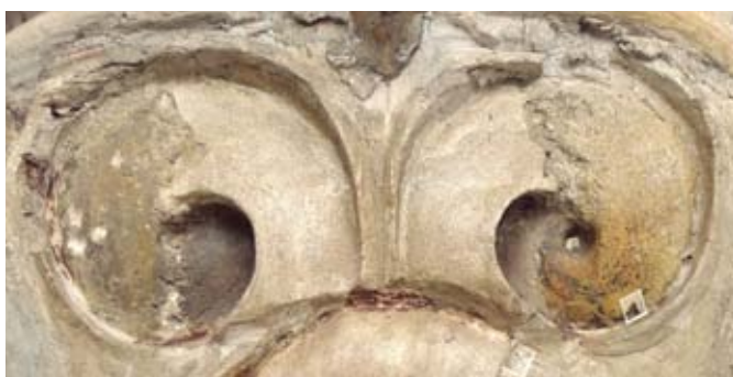
FIG. 158 Reprise au ciment des courbures de F13-a et b.
