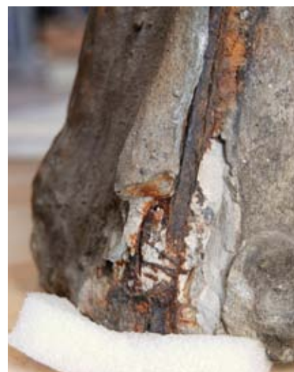
FIG. 136 Pied arrière gauche, barre de section rectangulaire enroulée d'un fil de fer.
