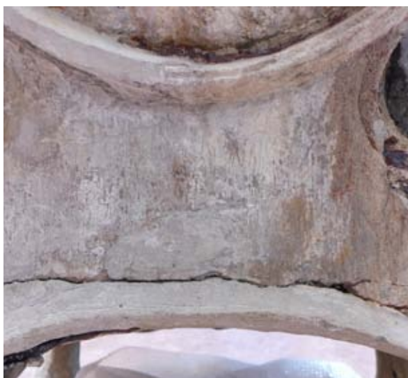
FIG. 237 Laitance potentiellement due à une recristallisation de la chaux en surface.
