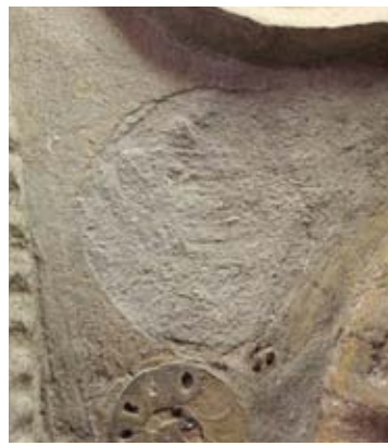
FIG. 286 Le même emplacement comblé lors de la réfection de 1978-1979 (vue en lumière rasante).
