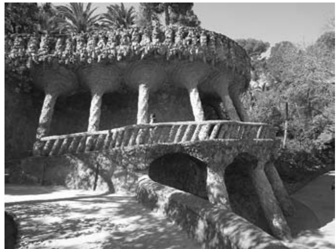
FIG. 102 Parc Güell, Barcelone, vue des piles du « viaduc ». Réalisation Antoni Gaudí, 1900-1914.
