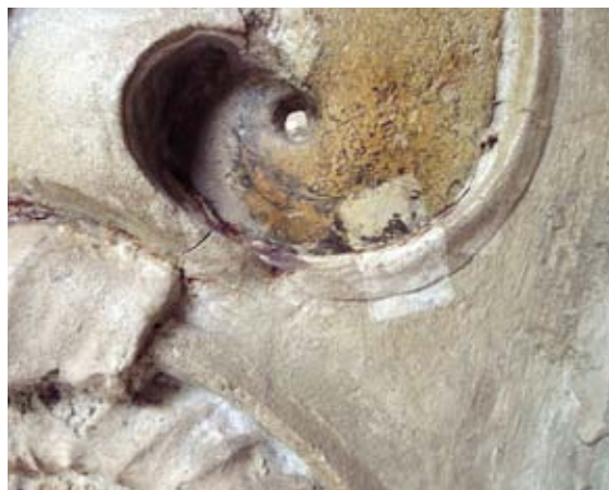
FIG. 294 Test de dévernissage au revers du dossier mettant en évidence le jaunissement des fossiles et du ciment.
