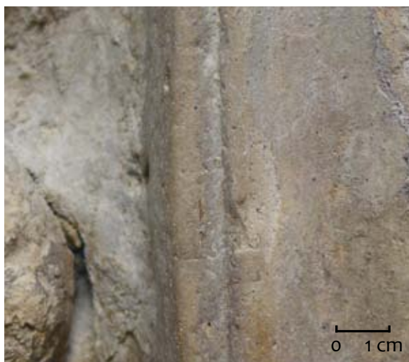
FIG. 226 Aspect du mortier de ciment original d'une moulure.
