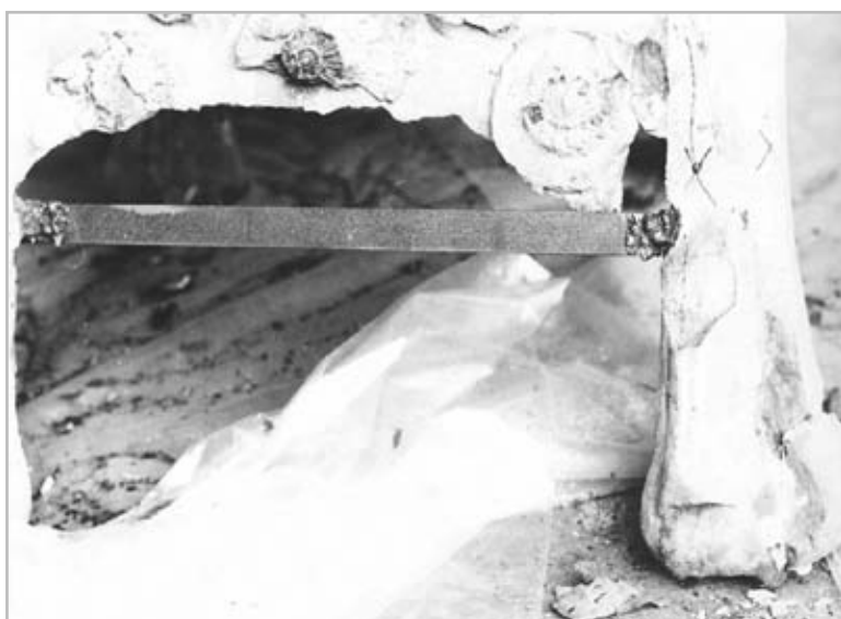
FIG. 177 Panneau droit, soudures à l'arc d'un nouveau fer plat (documentation T. Hodiesne, cliché n° 15).
