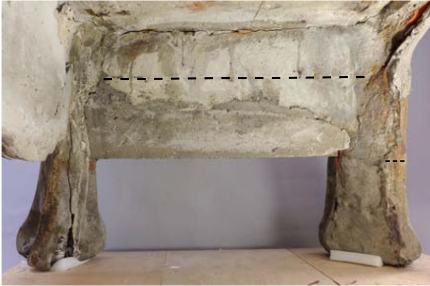
FIG. 137 Intérieur du panneau droit, délimitation des planches du coffrage original.
