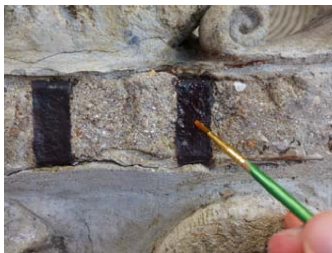
FIG. 387 Application au pinceau de Rustol Owatrol® sur les armatures accessibles.
