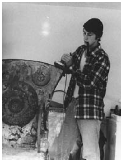
FIG. 176 Thierry Hodiesne décapant les armatures à la ponçeuse électrique (documentation T. Hodiesne, cliché n° 27).
