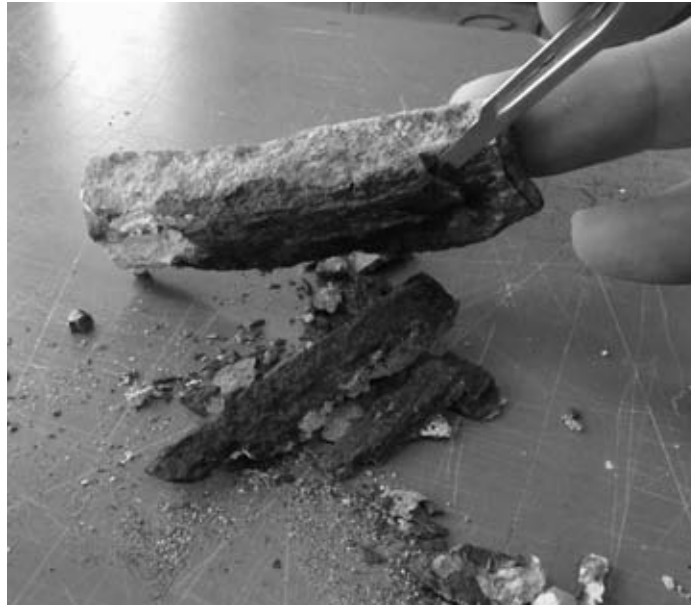
FIG. 360 Élimination au scalpel des produits de corrosion pulvérulents.
