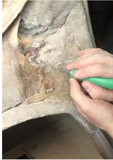
FIG. 374 Élimination de la coulure par projection de poudre d'alumine.
