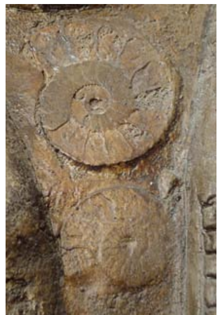
FIG. 162 Fossiles sciés sur tranche et incorporés dans le ciment (F7 et F8).
