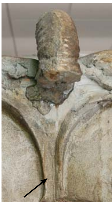
FIG. 316 Débordements et coulures de l'adhésif.
