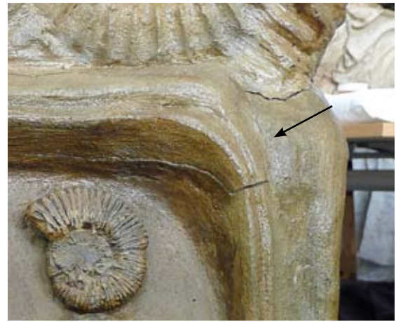
FIG. 253 Dislocation de la moulure d'angle du panneau droit.
