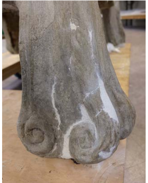
FIG. 408 Volute du pied avant droit après bouchage.
