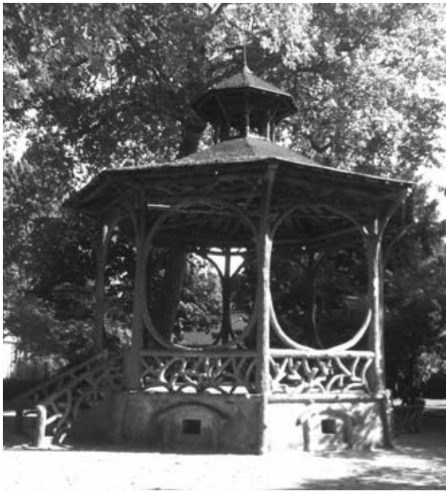
FIG. 97 Kiosque à musique en ciment armé, imitation bois, 1890, jardin Mirabeau, Tours.
