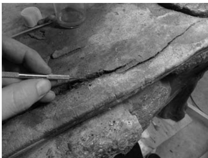
FIG. 401 Curage des fissures du bord de l’assise.
